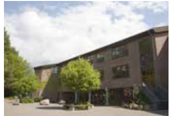
Das Schulgebäude der Gesamtschule vom Schulhof aus.
