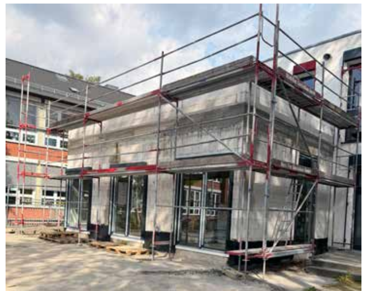
Die Arbeiten am Anbau unserer Schule sind weit fortgeschritten, aber noch nicht abgeschlossen.
